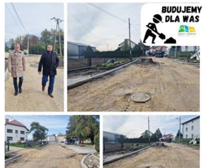
Modernizację odcinka ul. Wiejskiej od skrzyżowania z Węgierską do tzw. wąskiego gardła za ul. Zbożową, przy wylocie na Zerdziny
