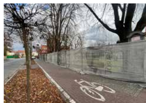
Przebudowa ogrodzenia terenu Zespołu Szkół ogólnokształcących nr 1 w Raciborzu od strony ul. Karola Miarki
