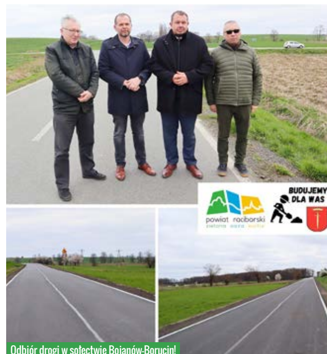
Odbiór drogi w sołectwie Bojanów-Borucin!
