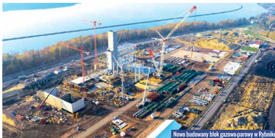
Nowo budowany blok gazowo-parowy w Rybniku
