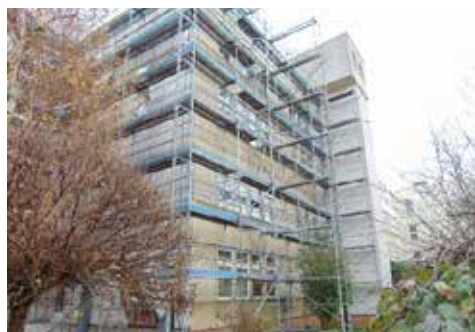
Termomodernizacja Domu Pomocy Społecznej „Złota Jesień” w Raciborzu
